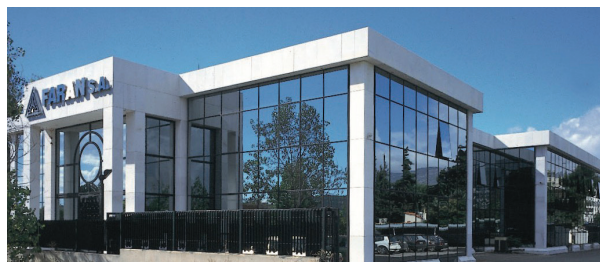
Οι εγκαταστάσεις της FARAN στην Κηφισιά
